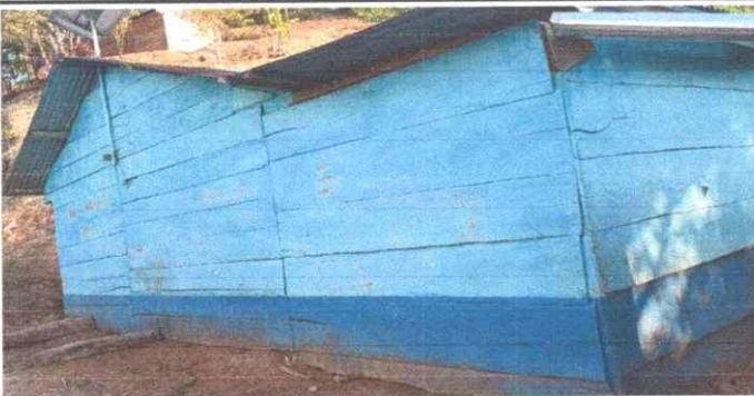
Foto 5: Sustitución cubierta de lamina por lamina troquelada.
